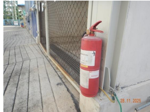
รูปที่ 3-30 ถังดับเพลิง บริเวณอาคารจัดเก็บกากของเสีย
