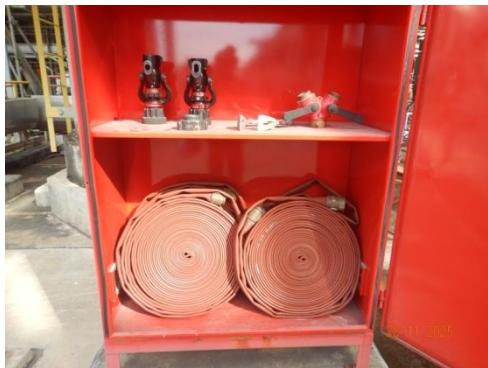
รูปที่ 3-55 Fire Water Nozzle
