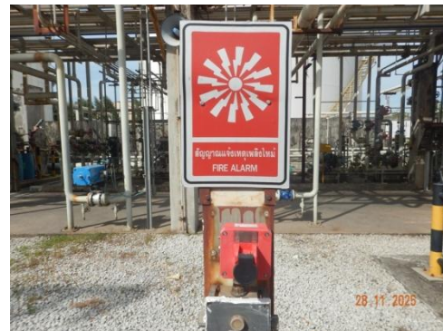
รูปที่ 3-52 Fire Alarm Manual System
