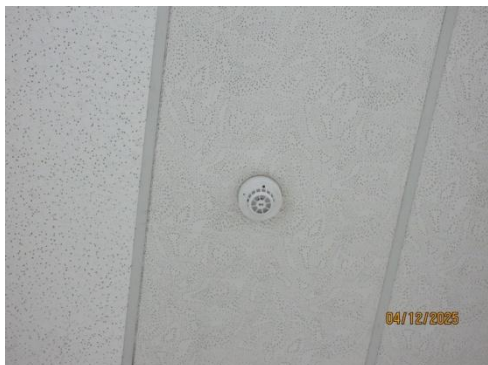
รูปที่ 3-51 Heat Detector บริเวณอาคารต่างๆ
