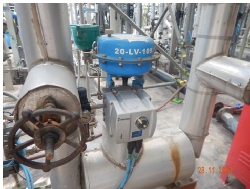
รูปที่ 3-37 Control Valve เป็นชนิด Low Noise
