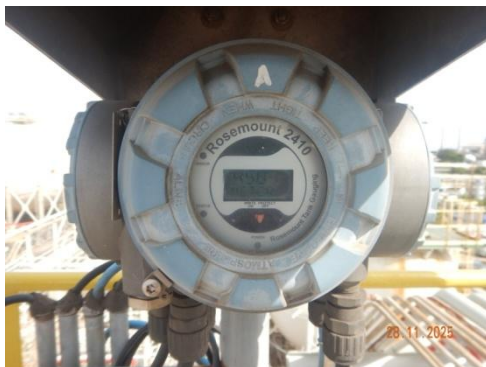
รูปที่ 3-66 อุปกรณ์วัดความดัน (Pressure Indicator) ที่ตั้งเก็บกัก
