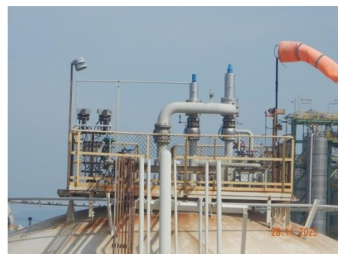
รูปที่ 3-69 วาล์วระบายความดัน (Pressure Relief Valve) ที่ตั้งเก็บกัก
