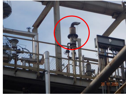
รูปที่ 3-36 อุปกรณ์ดัดเสียงที่ Ejector
