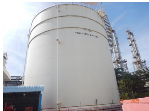
รูปที่ 3-14 ถังเก็บน้ำใช้ (Treated Water Tank)
