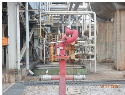
รูปที่ 3-74 Water Hydrant ในพื้นที่กระบวนการผลิต
