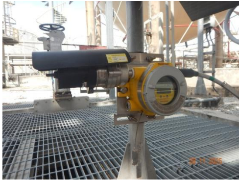
รูปที่ 3-70 Gas Detector บริเวณลานถังกักเก็บ
