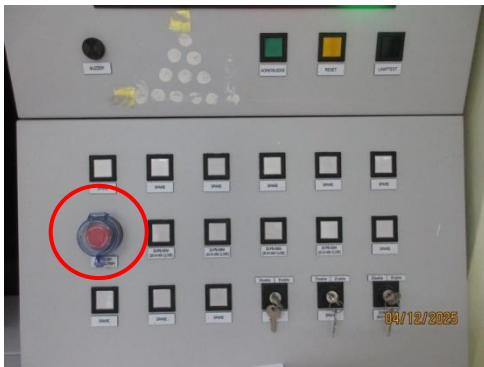
รูปที่ 3-7 Instrument Shutdown System (ISD)
