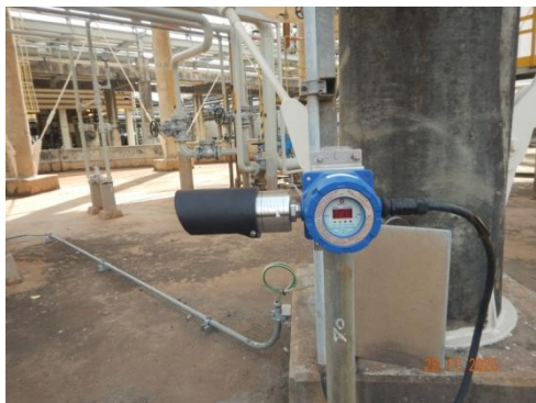
รูปที่ 3-49 Gas Detector ในพื้นที่กระบวนการผลิต
