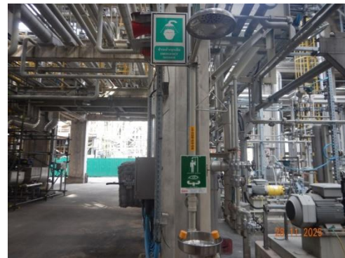
รูปที่ 3-56 อ่างล้างตา สักบัวล้างตา และที่ชำระล้างลูกเงิน
